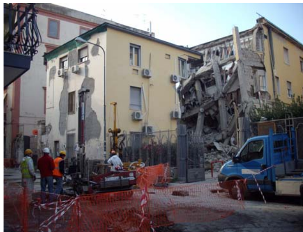
Foto 1: Il crollo di parte della Facoltà di Veterinaria
