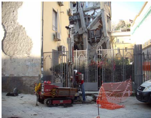
Foto 4: Una prova DPSH in corso
